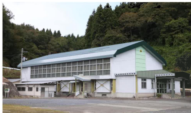
薄緑色がかかったグレーの屋根が蘇りました
